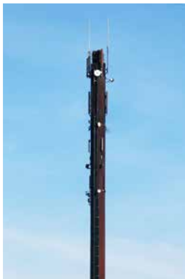
Antenner monteret på skorsten
