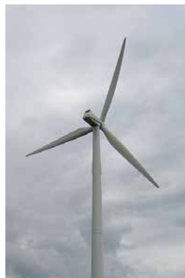
Antenner monteret på vindmølle
