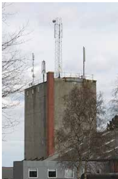
Mast/antenner placeret på bygning
