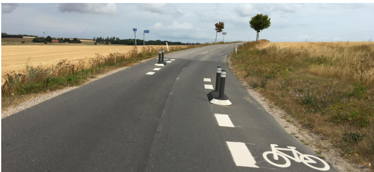
Figur 34 I Åstrup er der etableret fartdæmpning med chikaner og cyklistpassage 4 steder.
