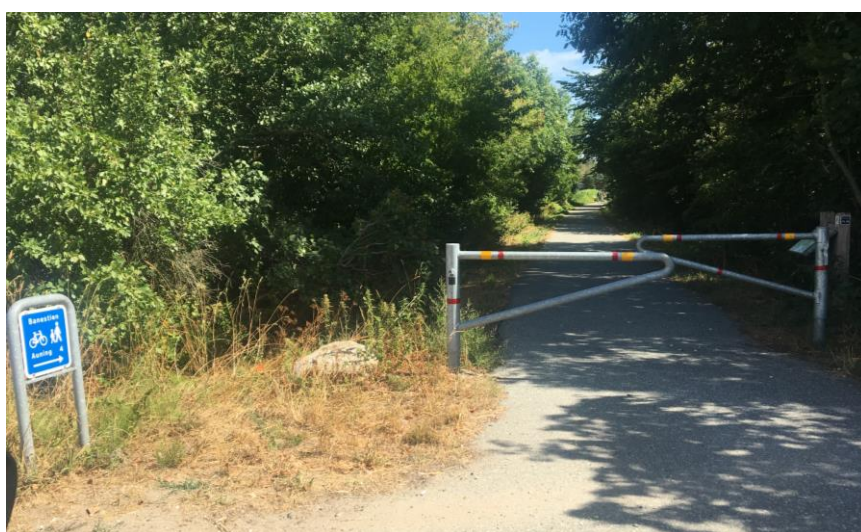
Figur 8 Banestien mellem Pindstrup og Allingåbro er en asfalteret sti i eget tracé og en god forbindelse der forløber i et fladt terræn på det gamle banelegeme
