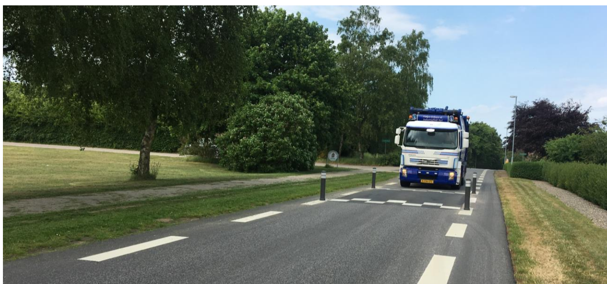
Figur 17 I Glesborg er der anlagt 2 minus 1 vej kombineret med en 40 km/t hastighedszone og flere hastighedsdæmpende foranstaltninger. Denne udformning anvendes mere og mere som en løsning til at forbedre cyklistforholdene på mindre veje med en del cykeltrafik.
