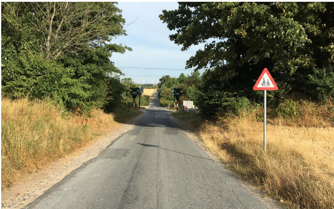
Figur 46 Baneoverskæringen på Homåvej før den blev lukket. Lukningen af overskæringen har givet store udfordringer for friskolen skolen.com, som er blevet afskåret fra både Homå og skolens udeareal på den modsatte side af banen.
