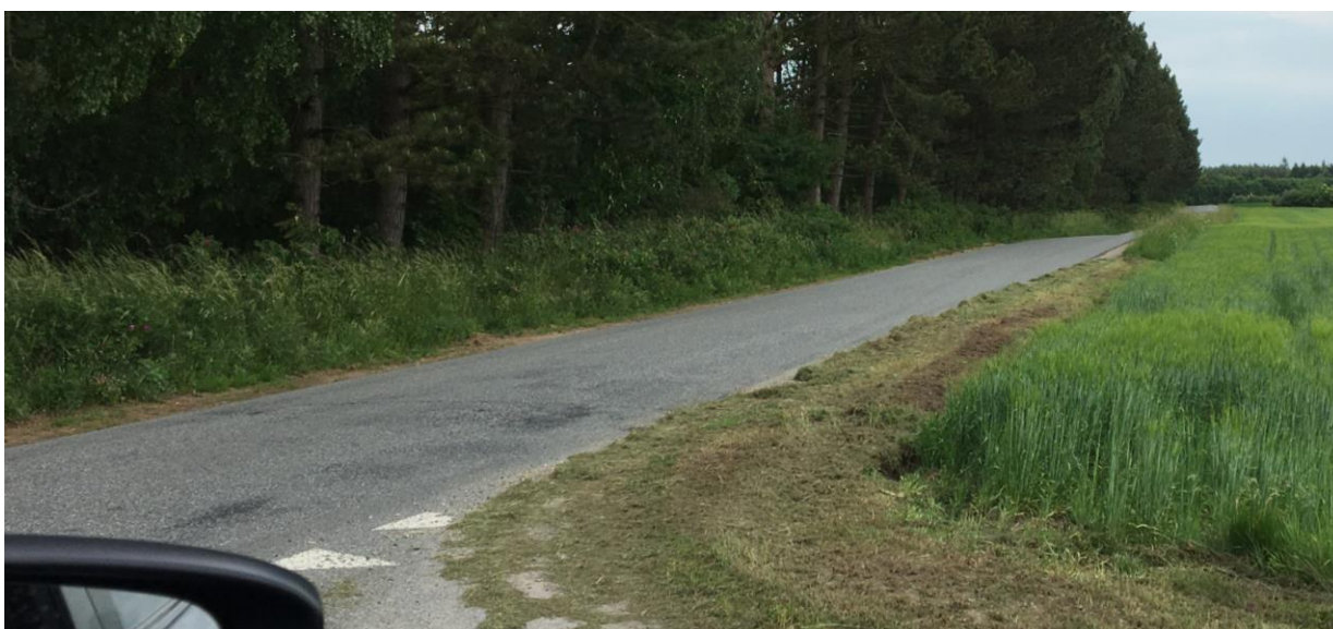
Figur 61 Gl. Fjellerupvej forløber ved skov ad et kuperet og kurvet vejtracé. Her set fra Nymøllevej mod øst.
