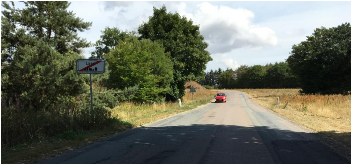
Figur 49 Mellem rundkørslen ved Glesborg og Laen er der en strækning på ca. 350 m i åbent land.
