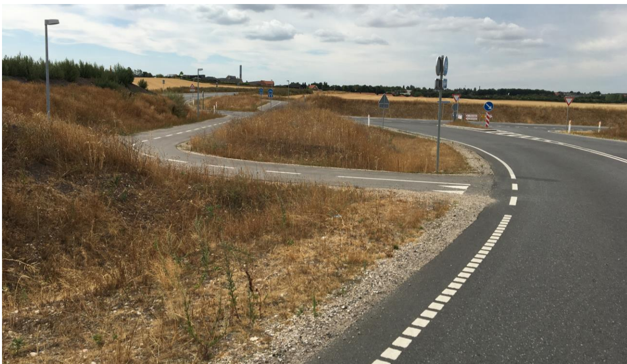
Figur 36 Ved Nordre Kattegatvej er etableret en kort strækning med dobbeltrettet cykelsti og en krydsningshelle ved stiens krydsning af Nordre Kattegatvej. Her set fra Hammelevvej.
