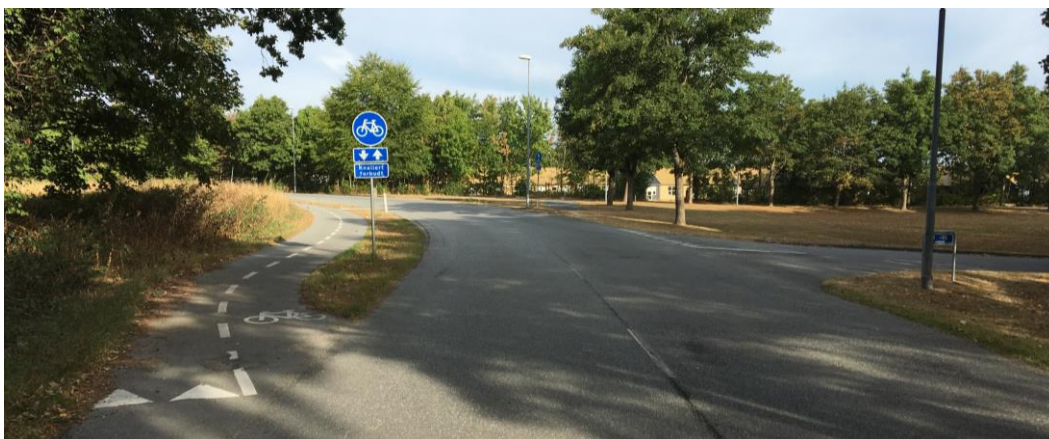
Figur 24 Den nuværende dobbeltrettede cykelsti på Fuglsangvej forløber fra Aarhusvej og stopper ved Trekanten.
