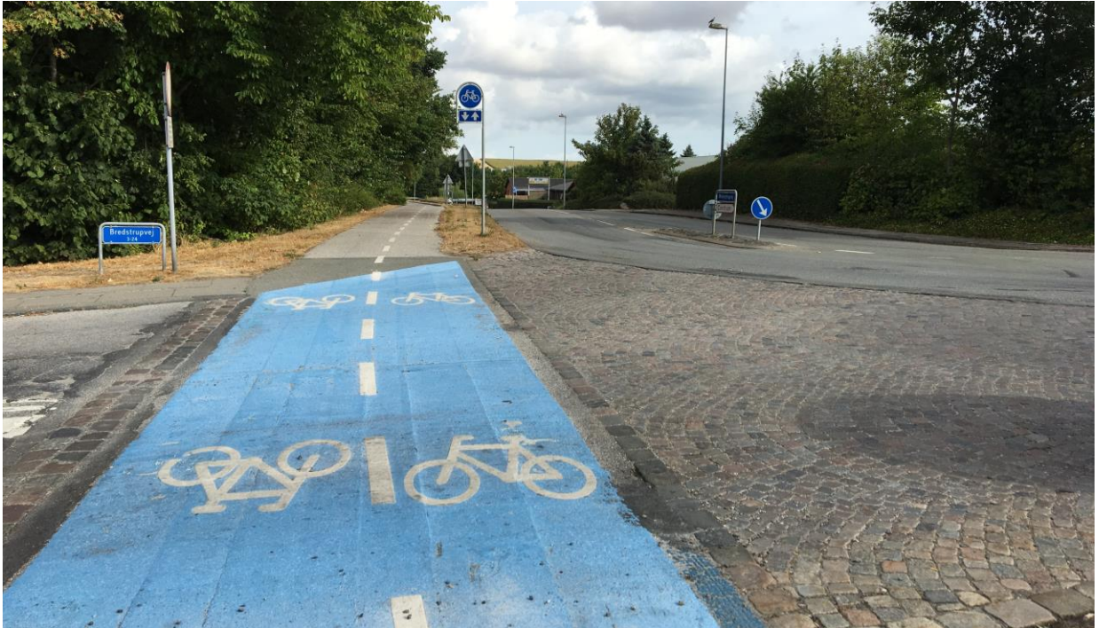
Figur 1 Norddjurs Kommune laver løbende trafikikkerhedstiltag til de bløde trafikanter. Her ses en dobbeltrettet cykelsti i Grenaa, hvor der er etableret en tydelig markering af stien med blåt cykelfelt i forbindelse med krydsning af en sidevej.
