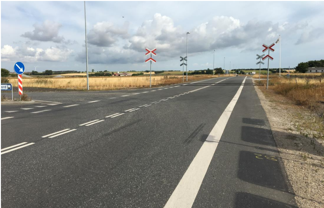
Figur 28 Fra Bredstrupvej er der etableret brede kantbaner og belysning videre frem til den nye omfartsvej Nordre Kattegatvej.
