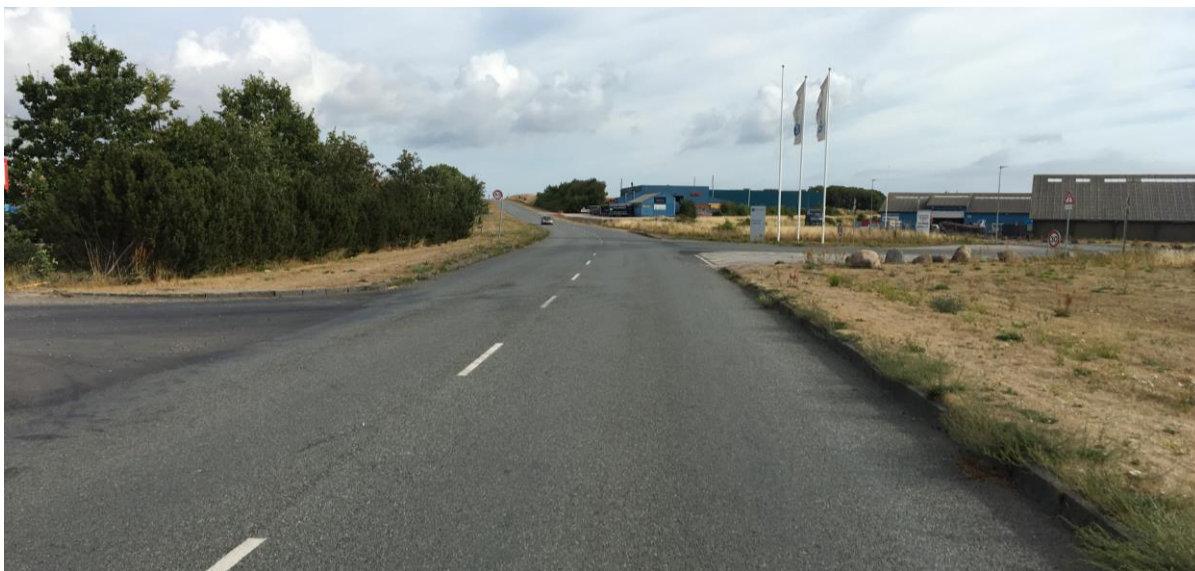
Figur 27 Kattegatvej forløber i åbent område tæt på industrihavnen i Grenaa. Det åbne tracé kan indbyde til kørsel med høj hastighed, hvilket kombineret med en del tung transport kan skabe utryghed for cyklister på strækningen.
